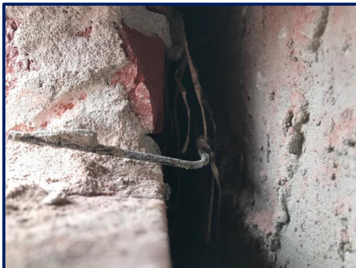
Afbeelding: Spouwanker dat niet loodrecht tussen het binnen- en buitenblad in het werk is opgenomen.
