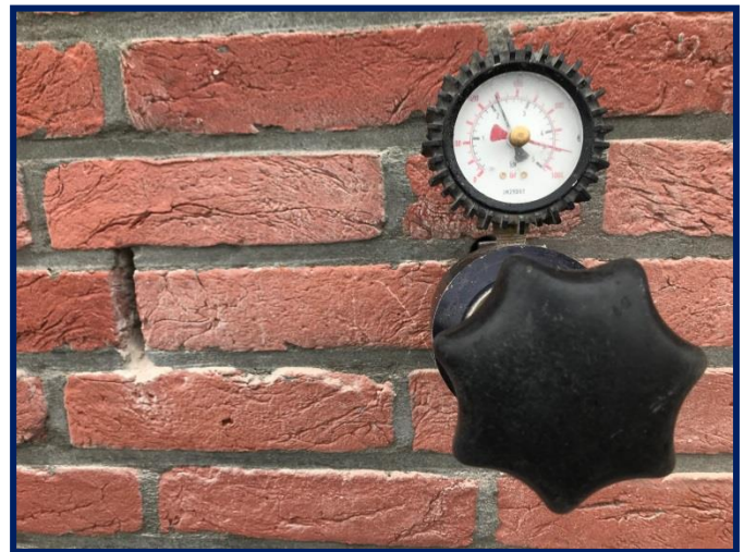
Afbeelding: De hecht- en buigsterkte van de metselspecie is voldoende.
