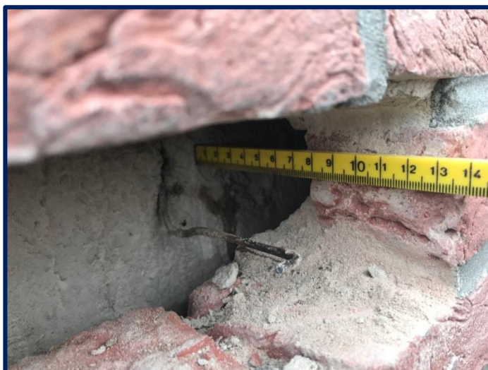
Afbeelding: De spouwdiepte is vrij constant en vastgesteld op ca. 40mm 1 .
