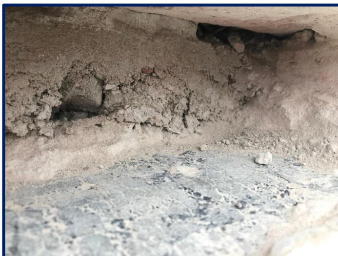
Afbeelding: Noemenswaardige hoeveelheid puin op ruberoid waterkeringen.
