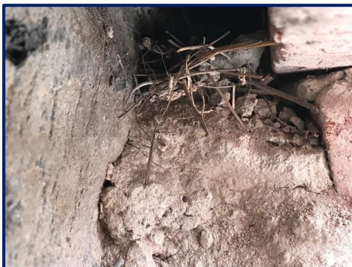
Afbeelding: Noemenswaardige hoeveelheid puin op ruberoid waterkeringen.
